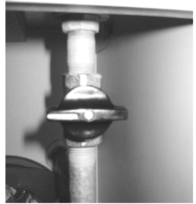
Sabe usted donde está la válvula principal del gas?
